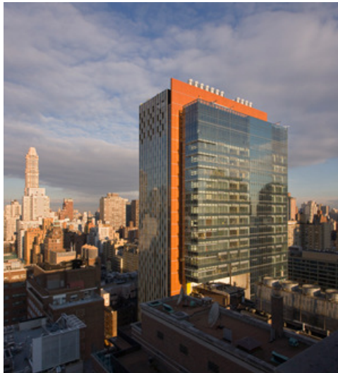
Zuckerman Building, MSKCC, New York 23 våningar hög skyskrapa med bara cancerforskning.
